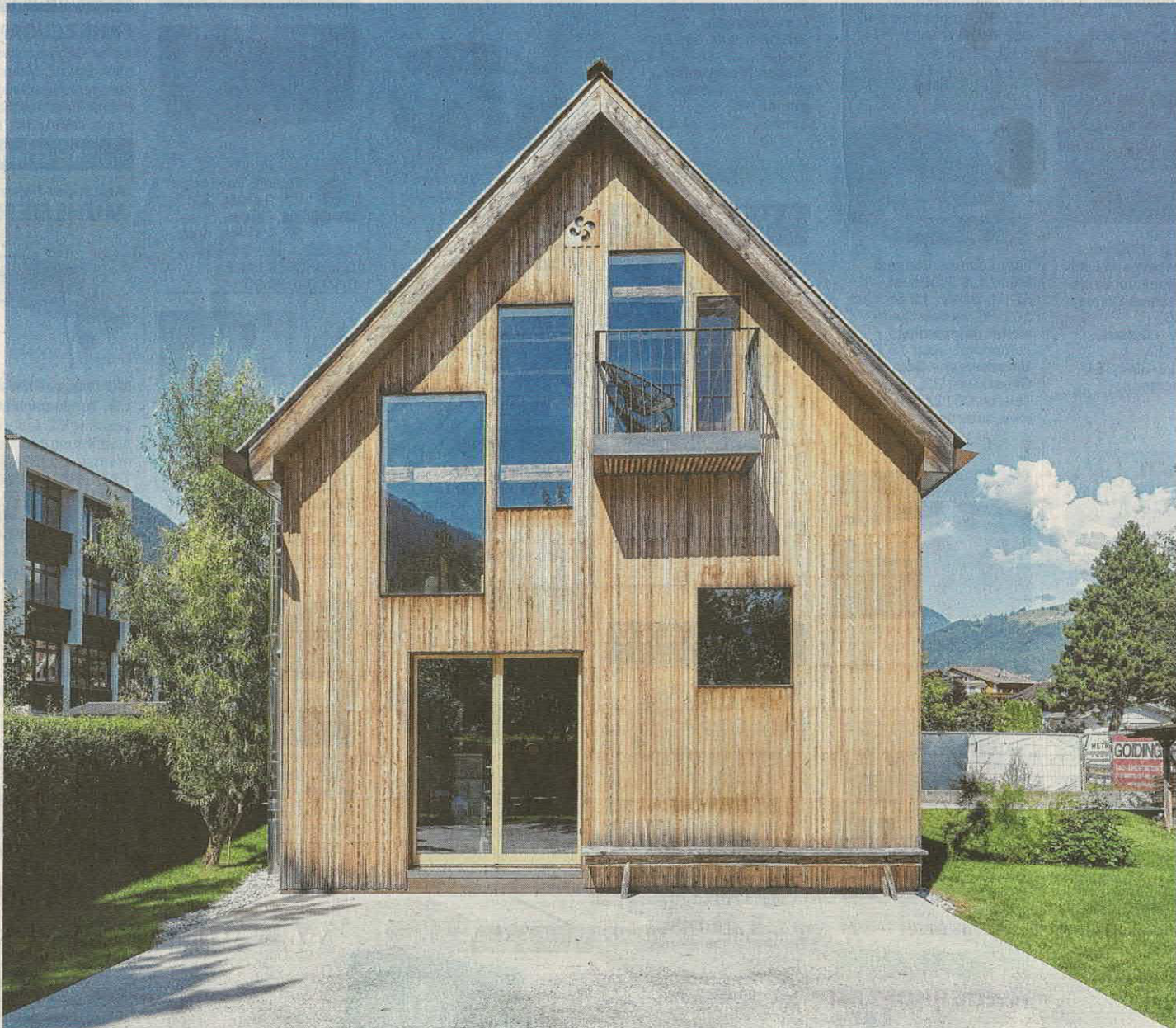
Balken für Balken abgebaut, jahrelang gelagert und zum „Raum für vieles“ wieder aufgebaute ehemalige Tenne in Fulpmes.
