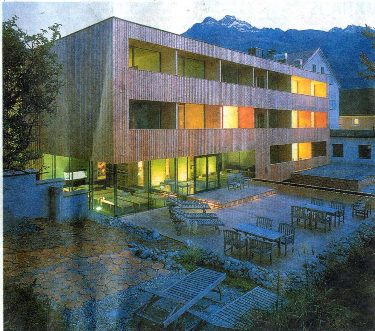
Den 1. Preis bei Gewerbegebäuden gewann das Hotel Hinteregger in Osttirol.
