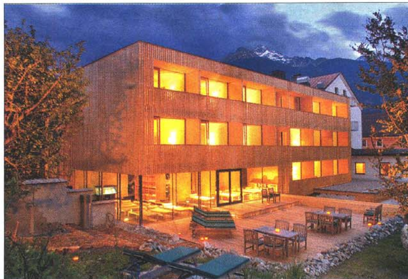
Ausgezeichnet: das neu gebaute Hotel Hinteregger.
