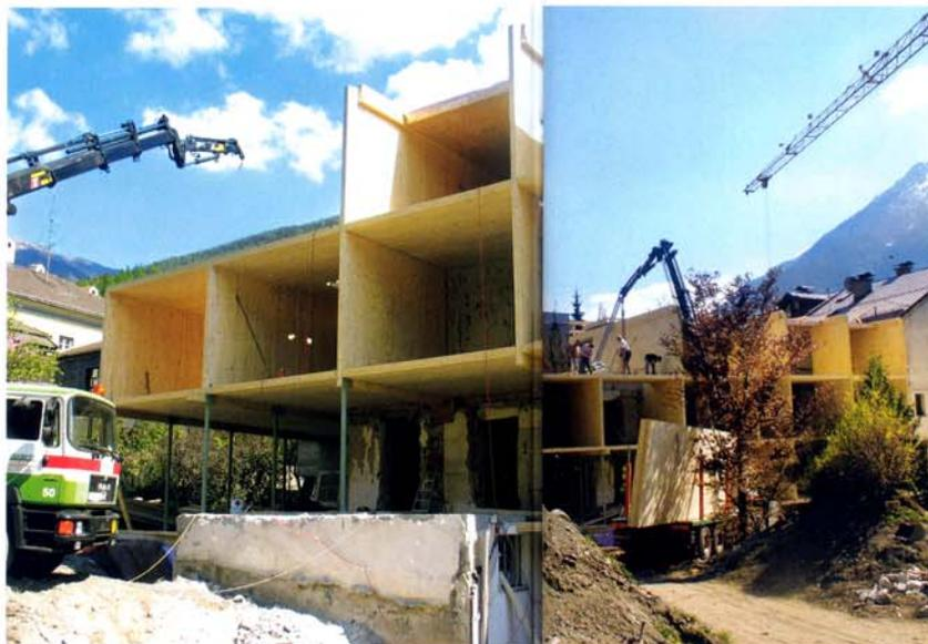
Die KLH-Wände wurden mit dem Kran versetzt und mittels Leimbindern in Deckenebene verankert.
