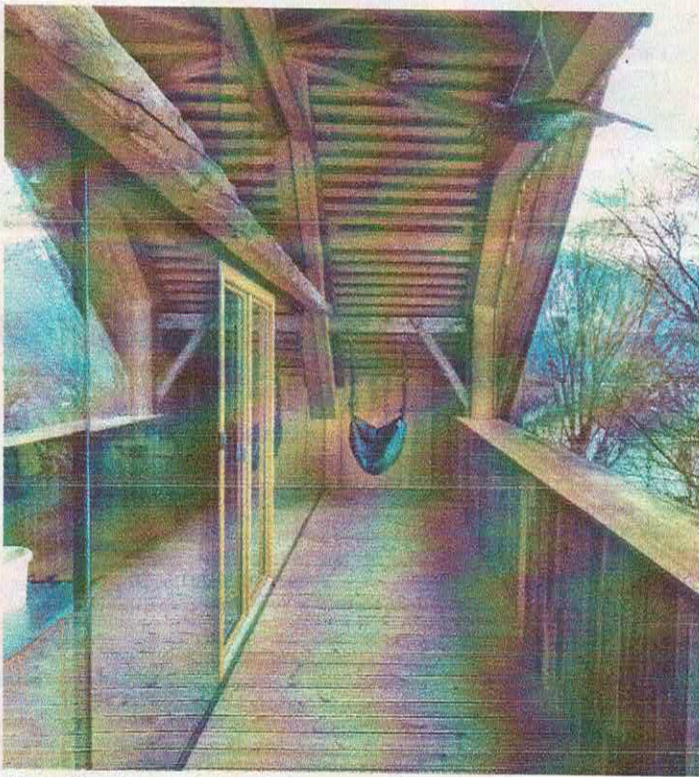
Die Loggia ist holzbeplankt, die „Wand“ zum Wohnraum aus Glas, jene vom Wohn- zum Schlafraum aus Holzlatten gebaut und mit strukturiertem Reispapier gefüllt.
