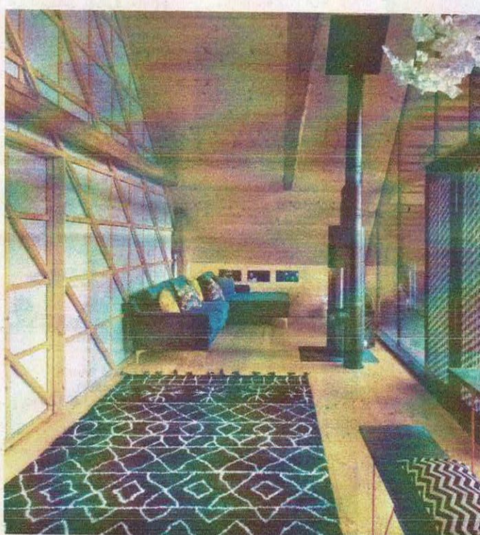
Die Loggia ist holzbeplankt, die „Wand“ zum Wohnraum aus Glas, jene vom Wohn- zum Schlafraum aus Holzlatten gebaut und mit strukturiertem Reispapier gefüllt.
