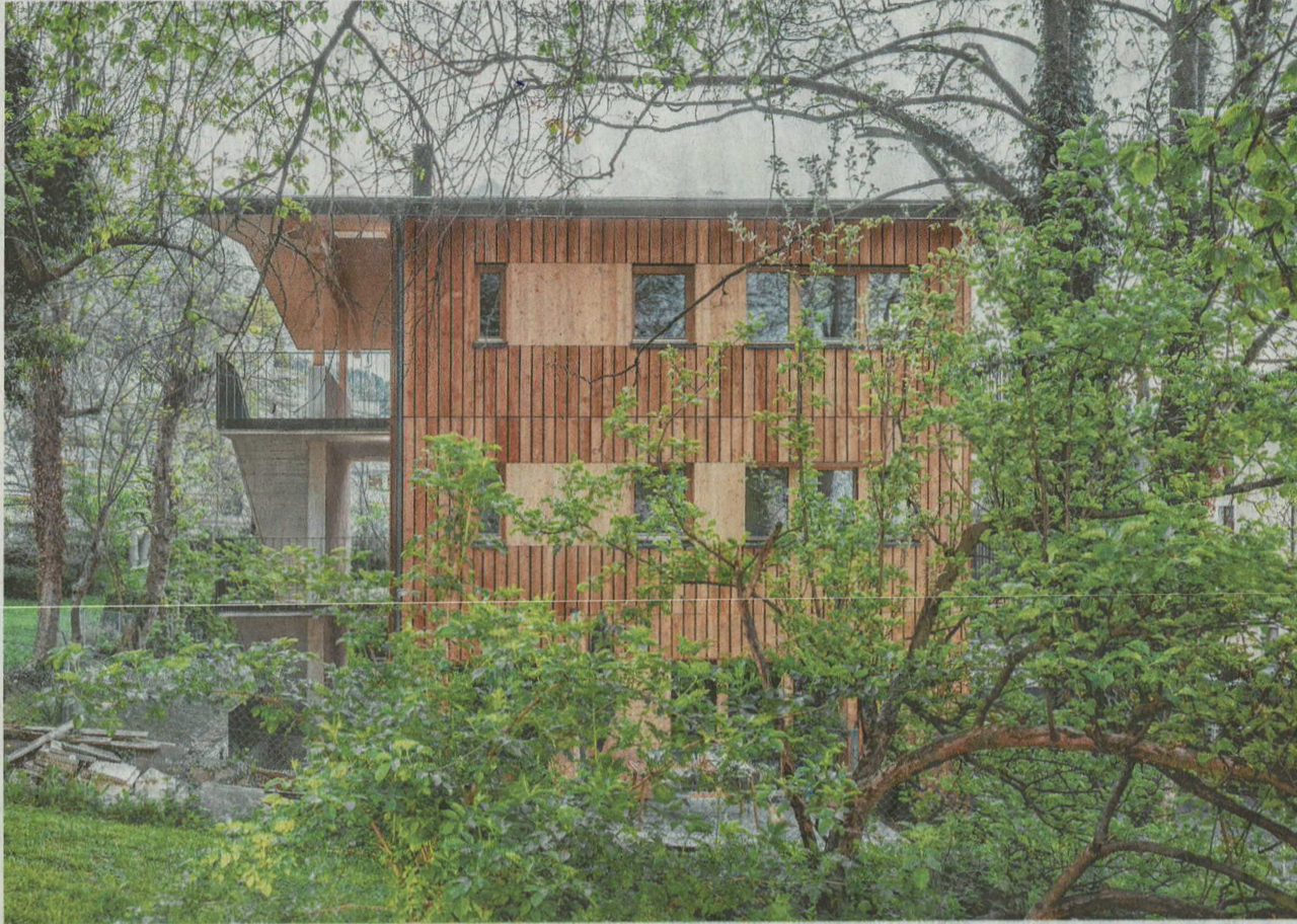
Die Fenster sind relativ klein, werden durch Zonen des Geschlossenen zu horizontalen Bändern, konterkariert durch die vertikale Verlattung.
